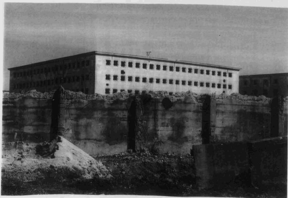
Visão geral dos pavilhões remanescentes
